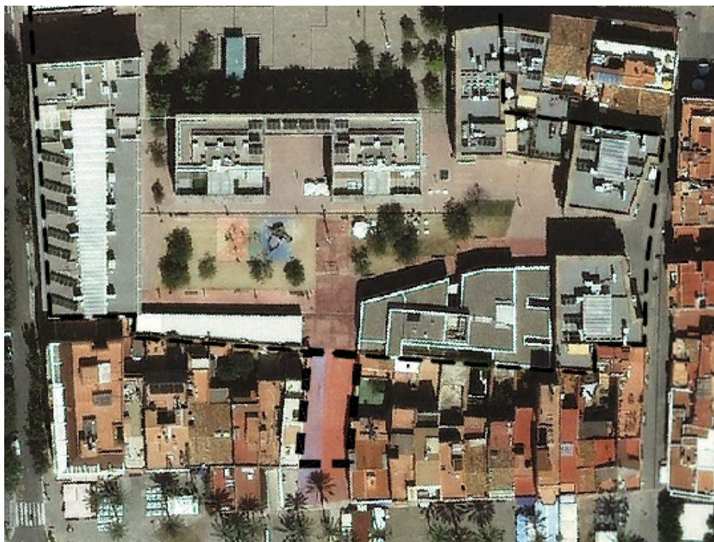
Finques al passeig del Carme 37-38 incloses en l'àmbit de la modificació
