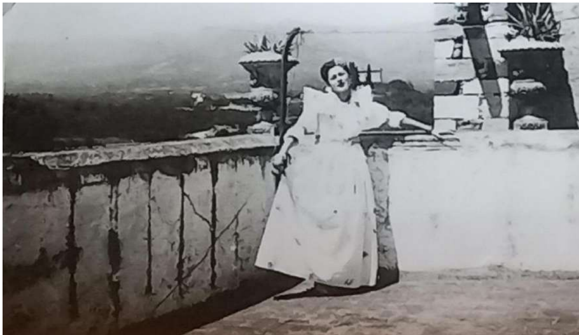
Fotografia presa al terrat de l'edifici on es pot observar la presència de vegetació, probablement atzavares, plantada a les copes que rematen la barana.
