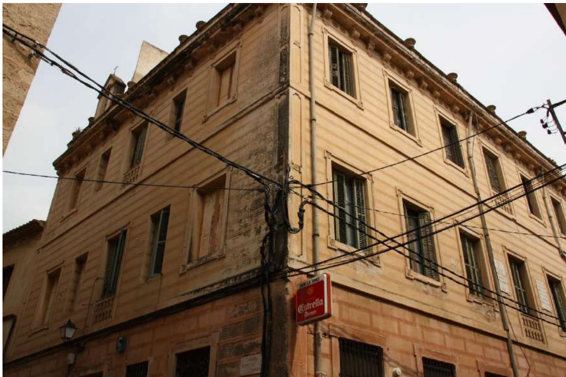
Fotografia captada el dia 4 de juny de 2009 on es veuen les persianes de llibret de les obertures de les plantes altes de l'edifici (autor: Pau Arroyo Casals).
