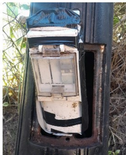
Il·lustració 1 - Caixa en fanal instal·lada en Granera.
