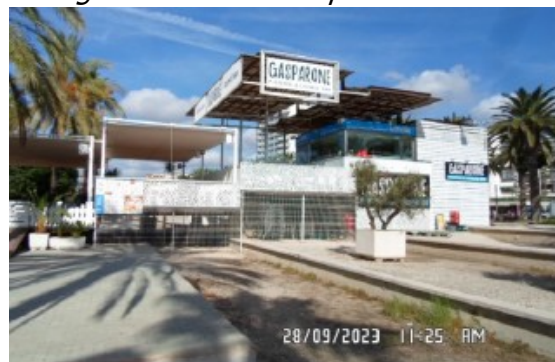
Configuració a data d'inspecció
