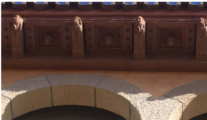
Foto 9 Els treballats ràfecs obra d'Ismael Porta
