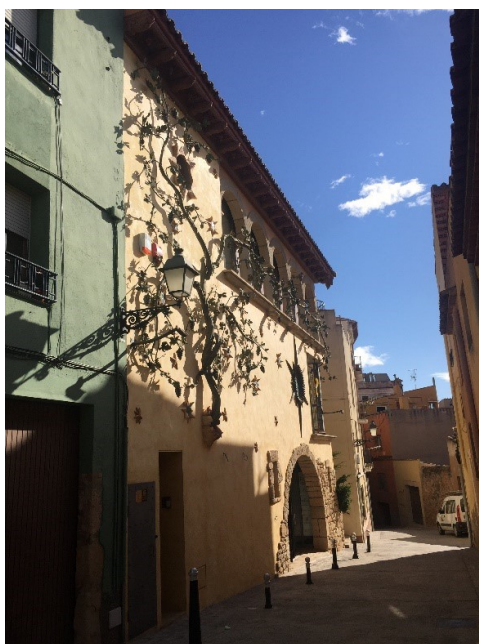
Foto 2 Vista de la façana principal del Carrer Solans
