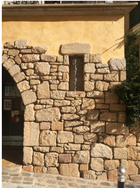
Foto 11 El treball en la pedra amb la junta enfonsada recordant una construcció en pedra seca
